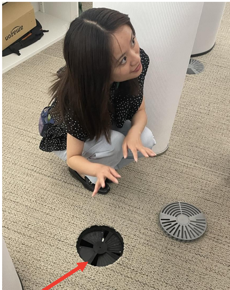
分區出風 可調式風門 調節區域溫度
